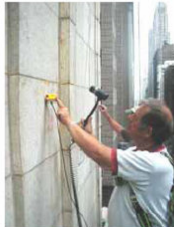
Buscando grietas o solturas en cubiertas de terracota
