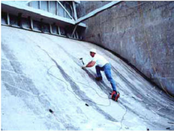
Pruebas en busca de delaminaciones en Vertedor de presa
