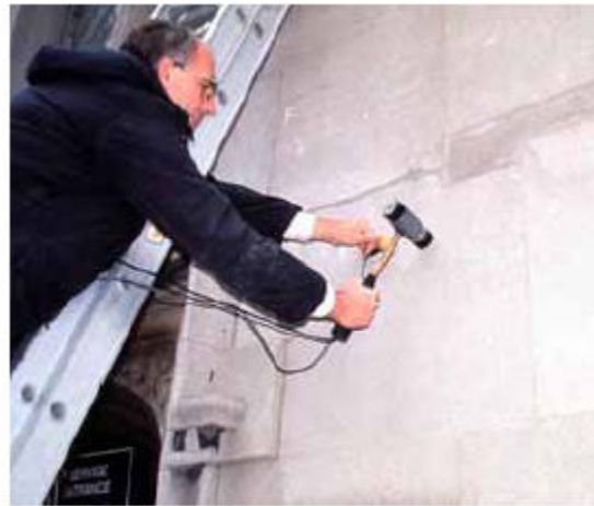
Buscando grietas y delaminaciones en mosaicos de piedra caliza
