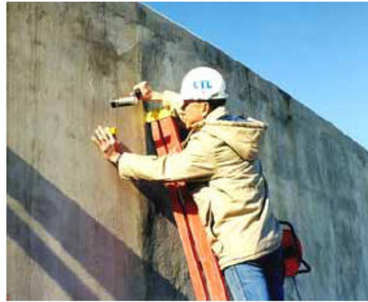
Prueba para evaluar unión en las juntas de un tanque de concreto
